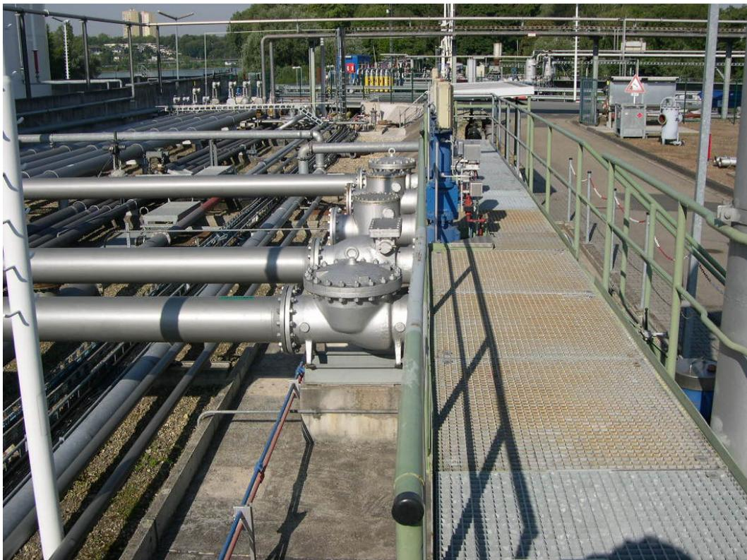
Abb. 4: Rückschlagklappen nach dem Manifold, Tanklager links
