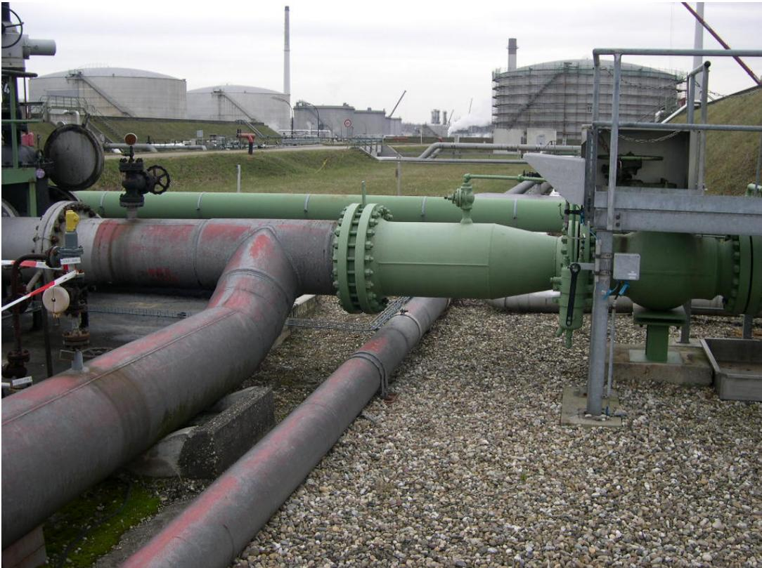
Abb. 6: Flanschverbindung zwischen Rohrfernleitung (grün) und Tanklager als definierte Schnittstelle
